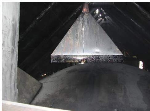
■④回収は排煙温度 80~150℃未満 ※ステンレス製フード
